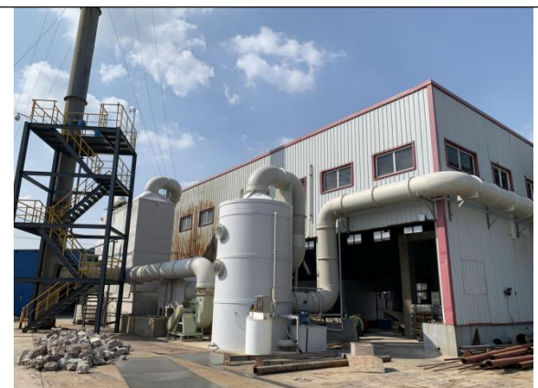
碱液喷淋装置+二段式生物滤池
